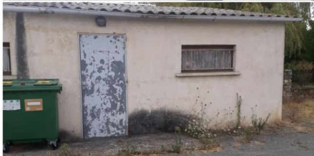
Réfection des Restos du Coeur
