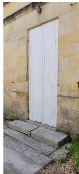
Réfection porte du presbytère
